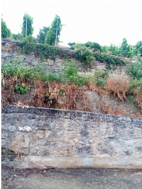
Abbildung 11: Unterschiedliche Zustände von Trockenmauern in den Weinbergen nördlich von Bönningheim. Zum Teil wurden bei Sanierungen der Mauern die Fugen versiegelt (Bioplan, 21.06.2023)
